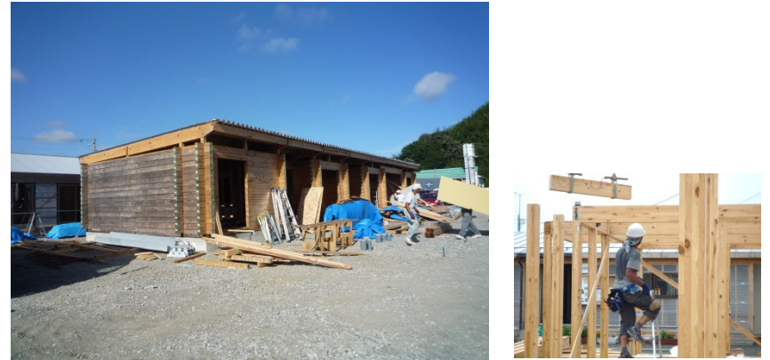
仮設住宅の移設作業現場(福島県)
